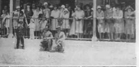
Un aspecto de la concurrencia que asistió a la inauguración y bendición de las veinticinco casas para obreros que ha construido la "Sociedad de Beneficencia Catalana", en el reparto "Aldecoa". —A la izquierda, la señorita Bebita Romagosa, madrina de la fiesta.
